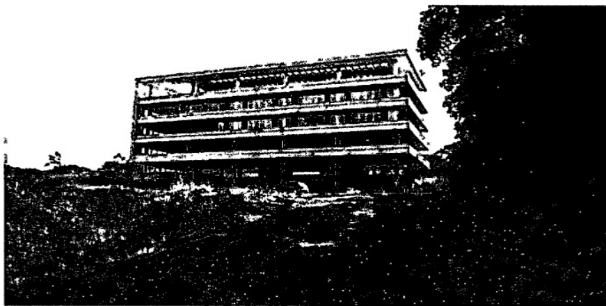
Foto 07 – ACESSO PELA RUA PROTÁSSIO WIPEL VISTA DO NOVO EDIFÍCIO EM CONSTRUÇÃO
